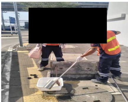
ภาพที่ 2.2-10 การเก็บตัวอย่างคุณภาพน้ำทิ้งก่อน-หลังการบำบัดภายในอาคารจอดแล้วจร
